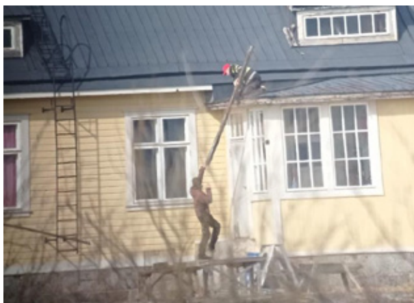
Jannes plåt installerar nya stuprännorna (foto Sebastian Andrejeff)
