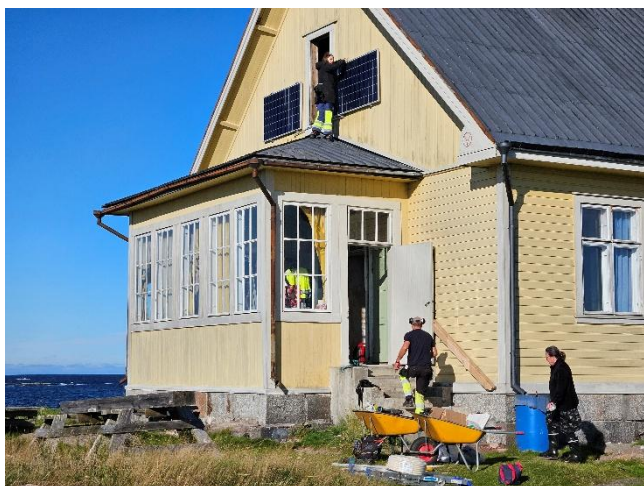
Elektrikerna jobbade på med att byta solpanelerna (foto Sebastian Andrejeff)
