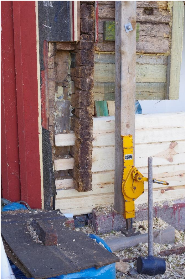
I hörnet mot verandan möts gammalt och nytt. Det gula verktyget (=domkraften) brukar av oklar anledning kallas "käring(fot)"
