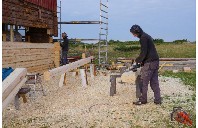
Olika verktyg i användnin: Handyxa, motorsåg och vinkelslip med "bilkinga"
