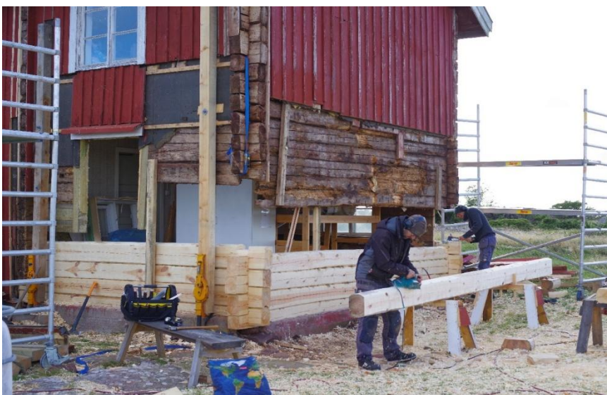
Timmerjobbet har börjat och två väggar "svävar i luften". Skickliga timmermän som utför ett utomordentligt arbete: Jonas och Elis.
