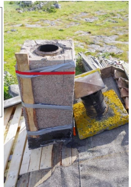
T.h. Sannolikt hade vatten trängt in under skorstenens "skyddshatt" och in i bergullsisoleringen. Borde vara tätat nu.
