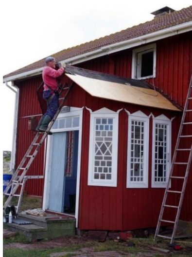
Antti T. Justerar kanten på tak faneren t.v. Det gamla brädtaket under är fortfarande felfritt, förutom i yttre kanterna, så det fanns ingen orsak att byta hela underlaget, allra minst mot virke av dagens undermåliga kvalitet. (foto Jörgen Eriksson)
