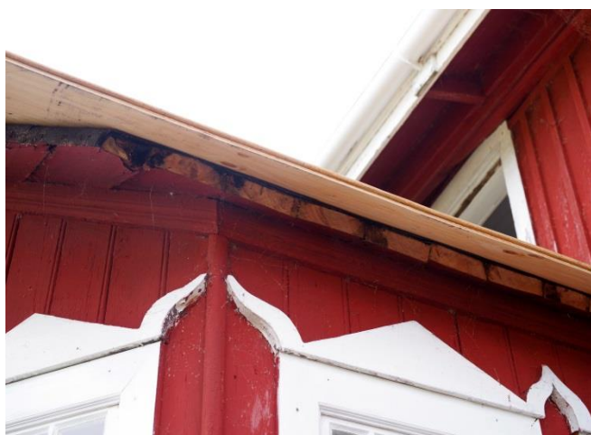
Mera material ut den 8.8. Skivorna används för att få takfallen kraftiga nog att kunna spika fast takfilten i, efter att ha fyllt undersidan med friskt trä. (foto Jörgen Eriksson)
