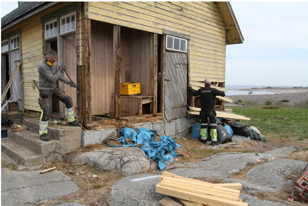
Demolering av utedassens väggar och vedlidrets gavel. (foto Johan Ekholm)
