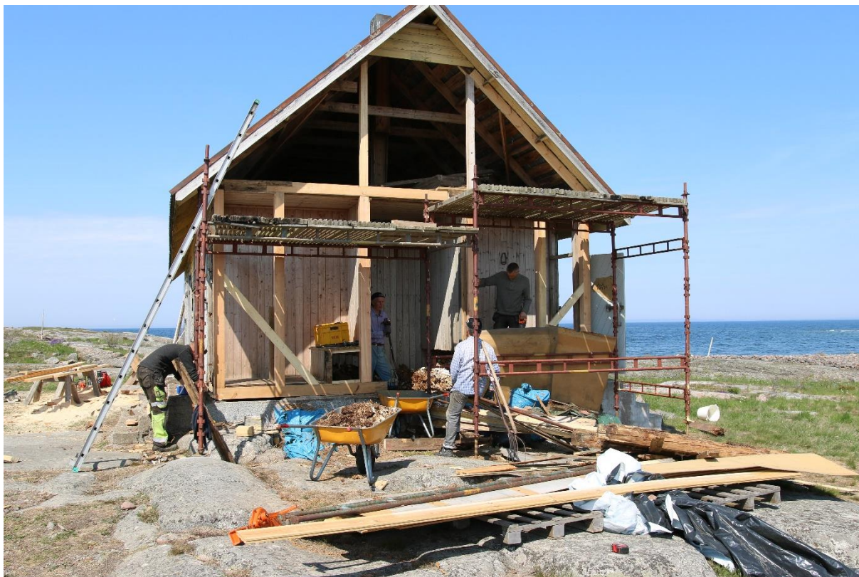
Tömning av utedassen. Medan Elis och Jonas bygger upp den nya stommen för väggen. (foto Johan Ekholm)
