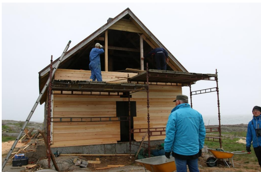
Åke och Per Anton bygger upp nya väggen. (foto Jonas Grönlund)
