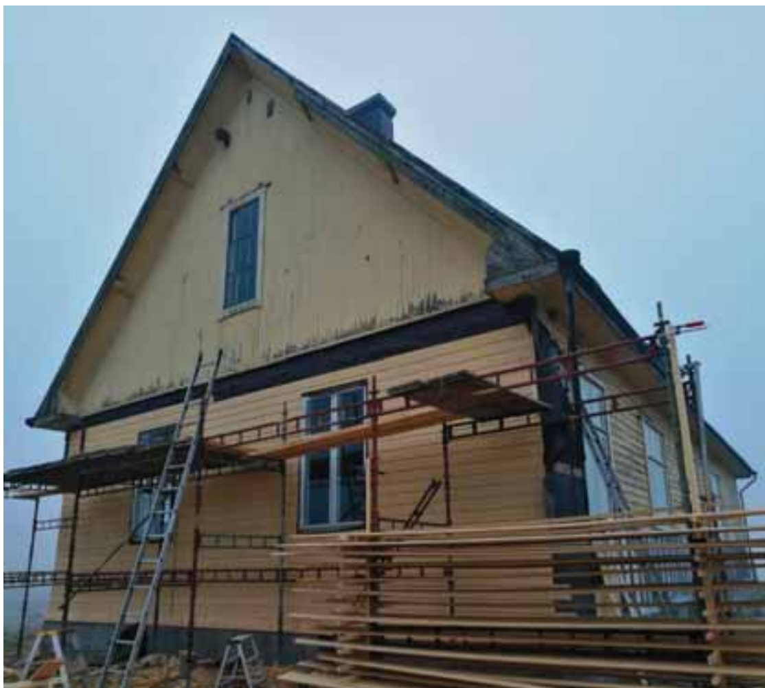
Panel läggning på norra gaveln (foto Sebastian Andrejeff)
