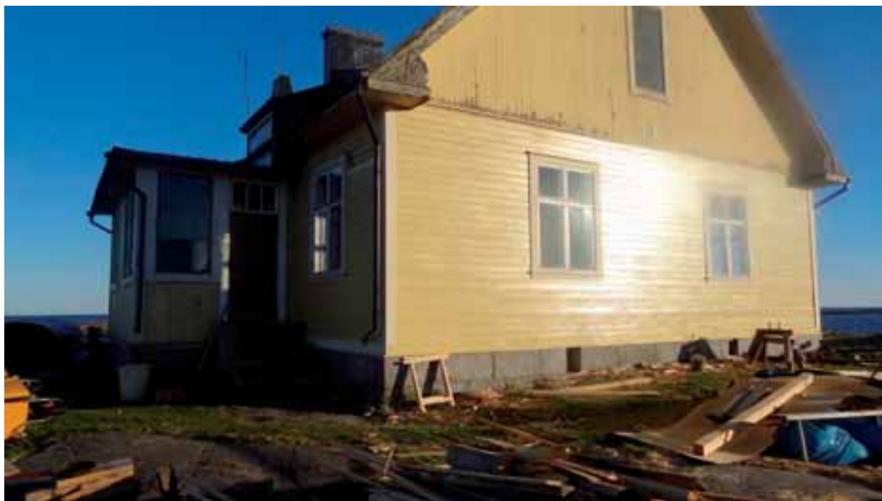
Lågskärs ny panelade norra gavel 2017. (foto Elis Bygghantverk)
